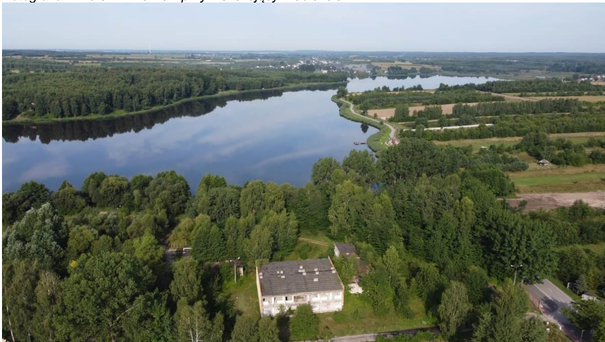
Fotografia 7. Zalew Drzewicki przy niszczącym obiekcie
