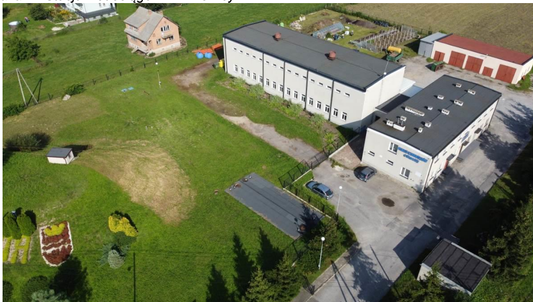
Fotografia 14 Stacja wodociągów w Drzewicy
