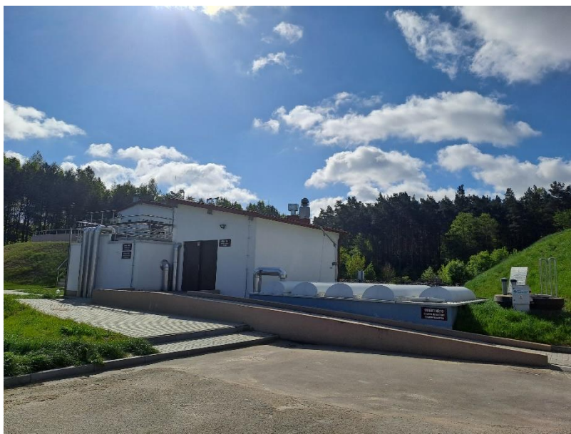
Oczyszczalnia ścieków w Drzewicy, ul. Słowackiego 26 Źródło: PGKiM w Drzewicy Sp. z o.o.
