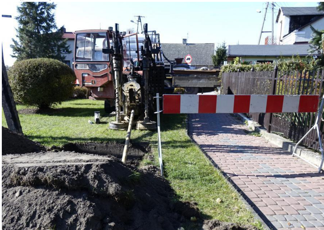
Fot. Budowa linii gazowej w Drzewicy
