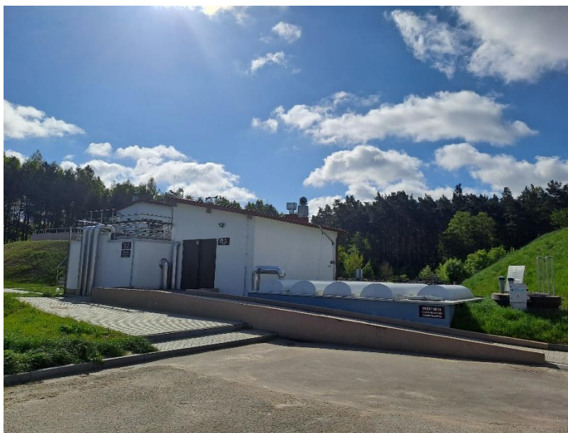
Oczyszczalnia ścieków w Drzewicy, ul. Słowackiego 26 Źródło: PGKiM w Drzewicy Sp. z o.o.
