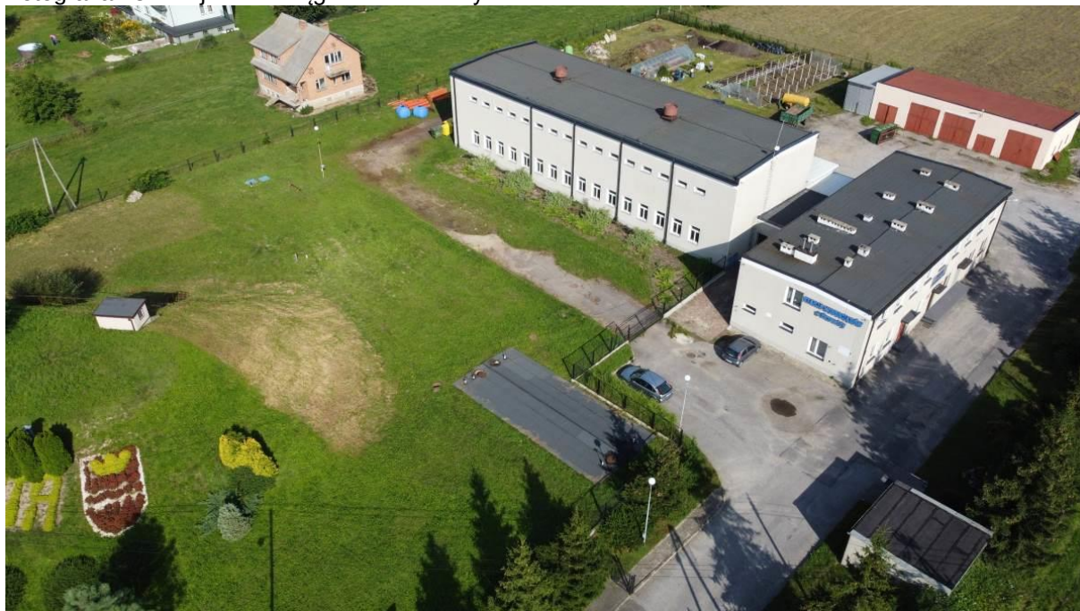
Fotografia 18 Stacja wodociągów w Drzewicy
