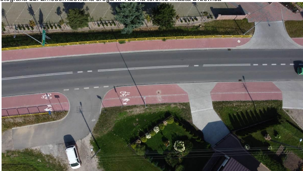
Fotografia 12. Zmodernizowana droga nr 728 na terenie miasta Drzewica
