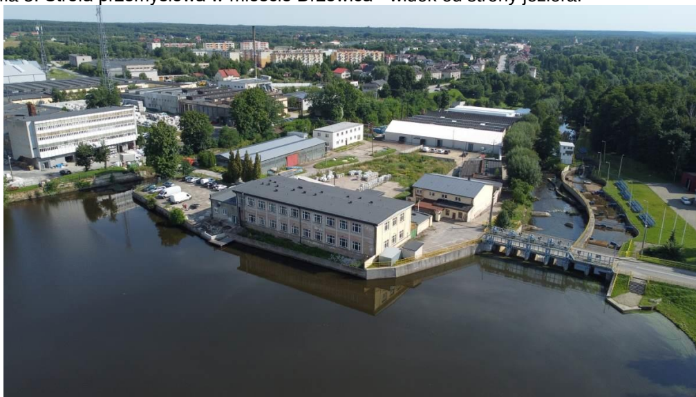
Fotografia 5. Strefa przemysłowa w mieście Drzewica - widok od strony jeziora.
