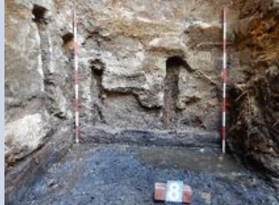
Szkic 19 Odkrywka 8 Stan drewna pod fundamentem
