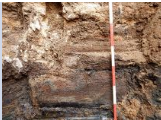
Szkic 27 Odkrywka 11, stan konstrukcji drewnianej
