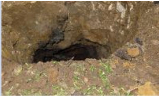
Szkic 32 Ściana 3-4 strona wewnętrzna, odkrywka fundamentu
