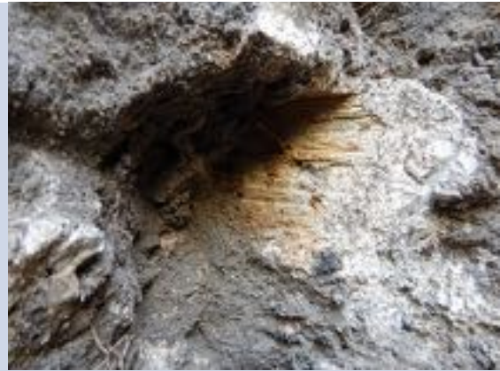
Szkic 19 Odkrywka 8 Stan drewna pod fundamentem
