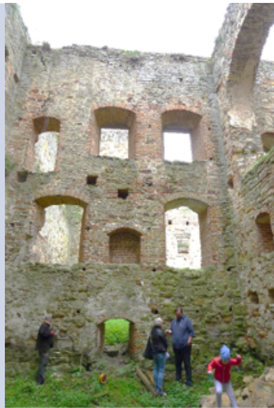
Szkic 12 Ściana 17-13, strona wewnętrzna, badanie struktury ściany, przewiert P2
