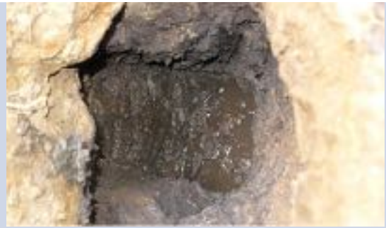
Szkic 33 Ściana 3-4 strona wewnętrzna, odkrywka fundamentu, drewniana część fundamentu
