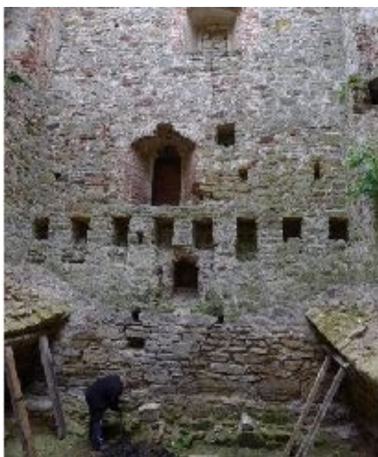
Szkic 30 Ściana 3-4 strona wewnętrzna, część dolna, odkrywka fundamentu
