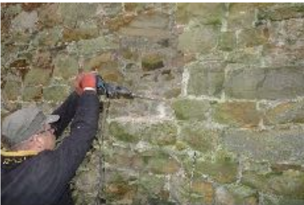
Szkic 10 Ściana 5-6 wewnątrz, badanie struktury ściany, przewiert P1
