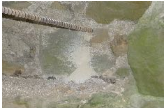
Szkic 11 Ściana 5-6 wewnątrz, badanie struktury ściany, przewiert P1
