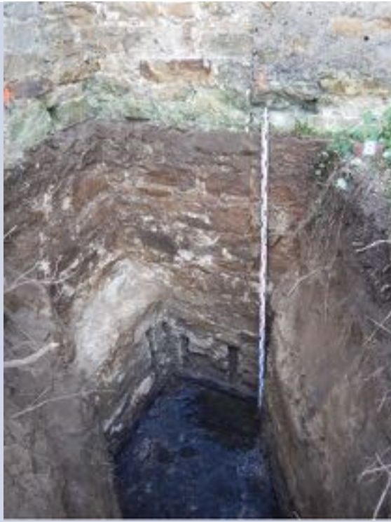
Szkic 19 Odkrywka 8 Stan drewna pod fundamentem
