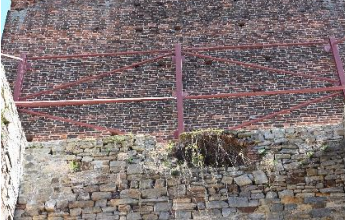
Szkic 6 Stalowa konstrukcja awaryjnego podparcia attyki
