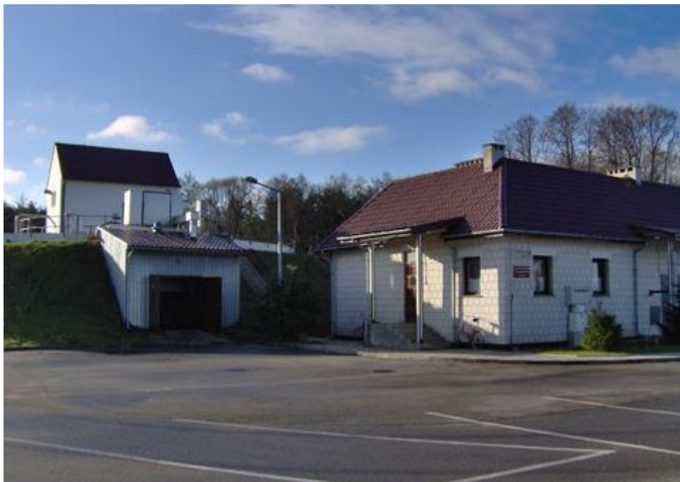
Oczyszczalnia ścieków w Drzewicy, ul. Słowackiego 26 Źródło: UM w Drzewicy
